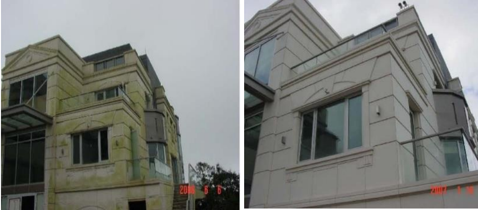
شكل رقم (٣) استخدام مواد النانو على الواجهات والشكل قبل وبعد الاستخدام
