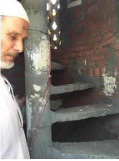
شكل رقم ٩ الشيخ منصور يشرح كيفية تثبيت إحدى درجات سلم المئذنة
