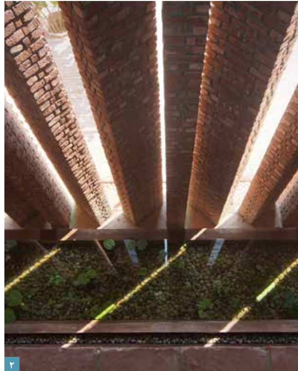
٢. الجدار الخارجي يعمل كمرشح للضوء داخل قاعة الصلاة.
