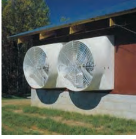
شكل (16) تركيب مراوح التهوية بالحوائط الخارجية
